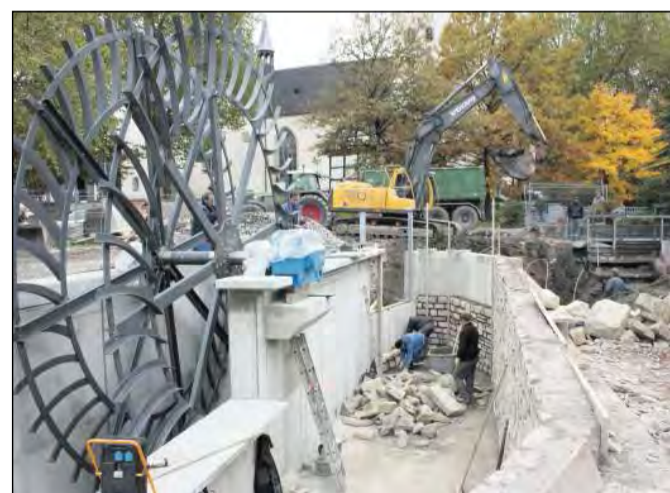
Imposant: Mit sechs Metern Durchmesser, dreieinhalb davon in sichtbarer Höhe, ist das Wasserrad schon jetzt ein Blickfang.
